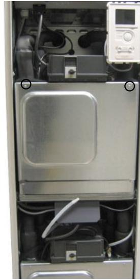
**4** Lösen Sie den elektrischen Anschluss an der Umwälzpumpe.
